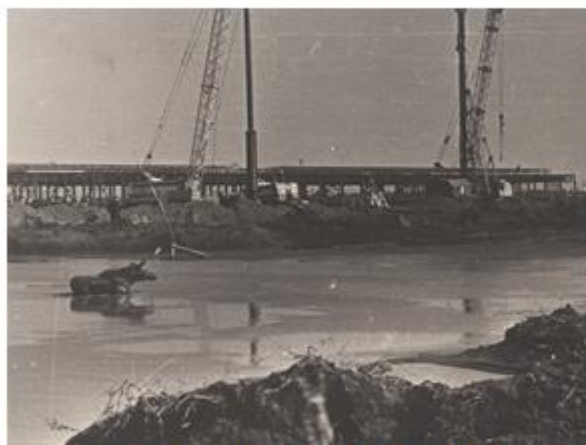
Строится Автосборочный завод, 1973 год. В начале строительства КАМАЗа такая картина была не редкость.
